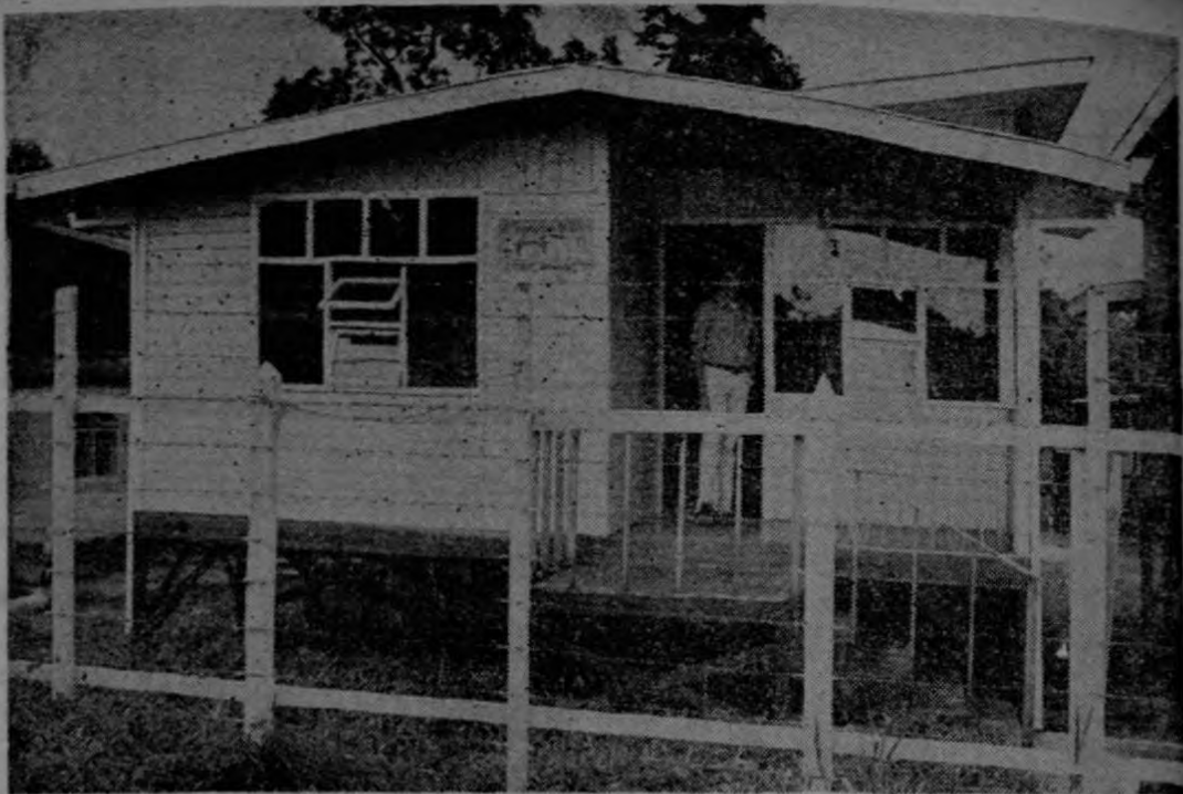
CASA MODULAR. —El cliente puede escoger este tipo de vivienda: tres dormitorios, sala, comedor, cocina. Puede solicitar que la levanten y construir abajo un garage, una bodega, etc. Se la pueden levantar en el tiempo que usted crea conveniente y donde usted lo desee. El precio también es modular.—(Foto Córdoba).
